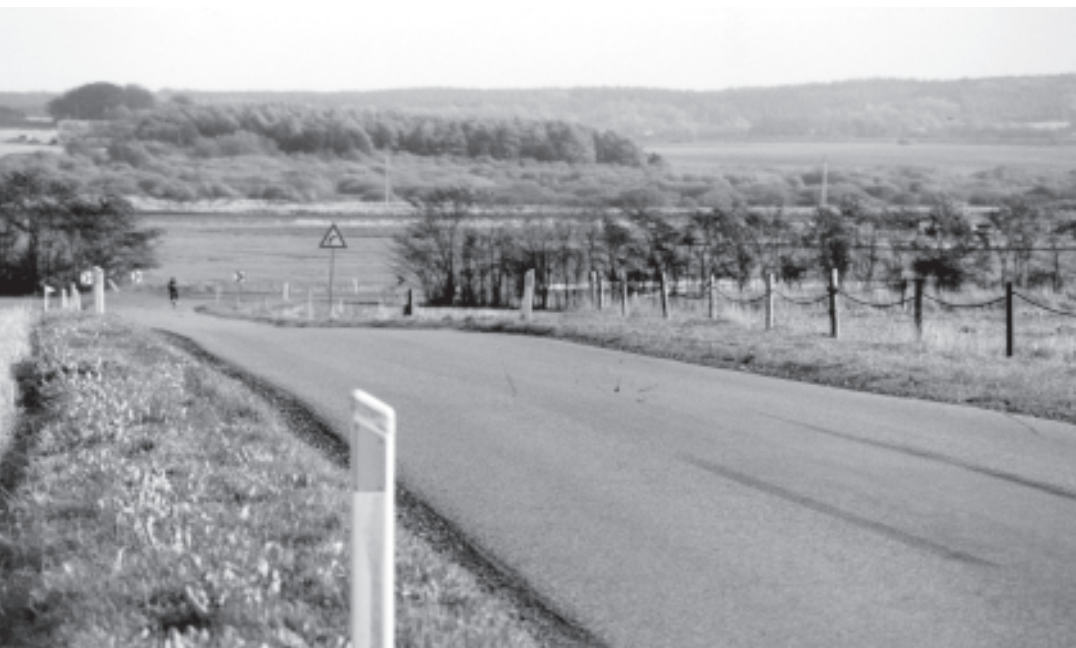
Malerisk var udsigten fra Poulstrup mod øst ned over Tollestrup mose. Tollestrupvejen blev som en af de få veje afbrudt ved motorvejsanlægget.
