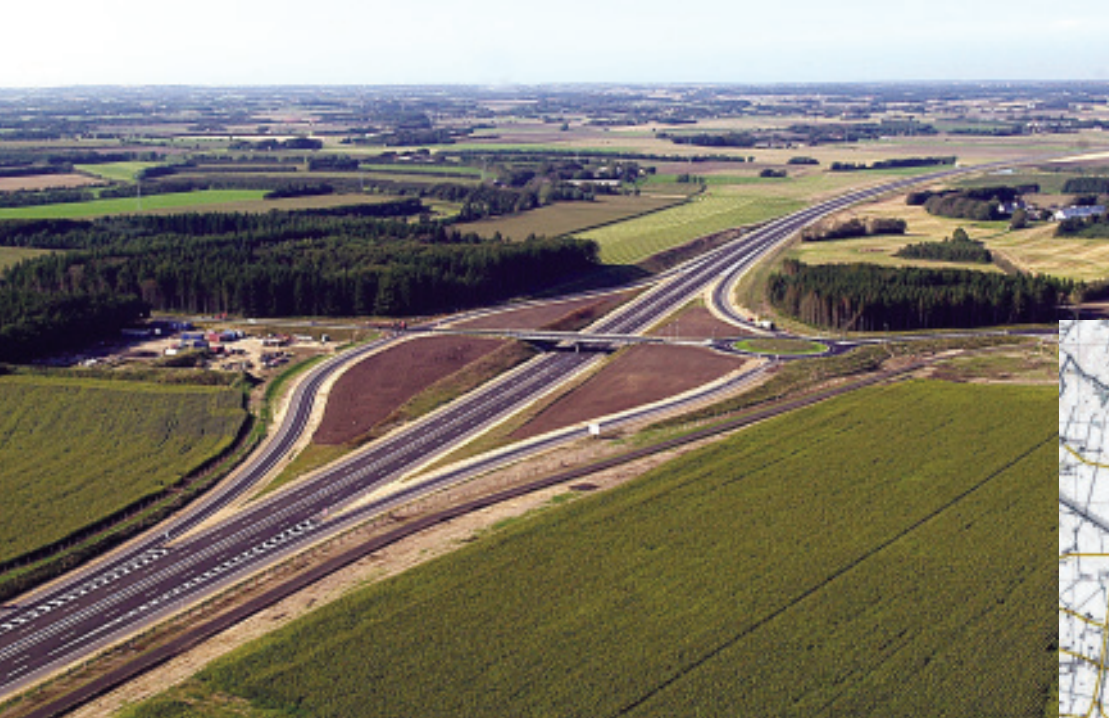
Øverst: frakørsel 5, Vrå, ved Vrejlevklostervej I midten: Vrejlev Kloster med omfartsvejen Nederst: Poulstrup mod vest med regnvandsbassinet ved Ladegård. Alle billeder set mod nord
