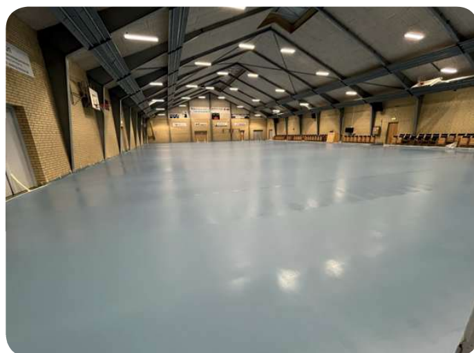
Her har gulvet netop fået ny gulvbelægning, men mangler stadig topcoating, opstregning og kantlister.
