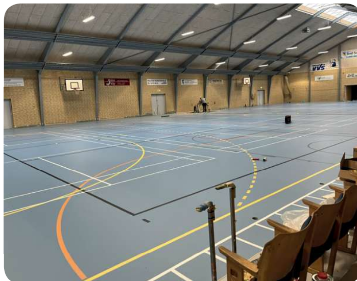
Opstregningen er færdig.
