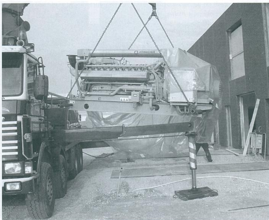
En af de 2 Jenbacher motorer på hver cirka 1500 hk
