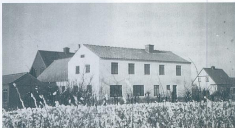
Det store værksted bag ved møbelforretningen, bygningen er i dag nedrevet
