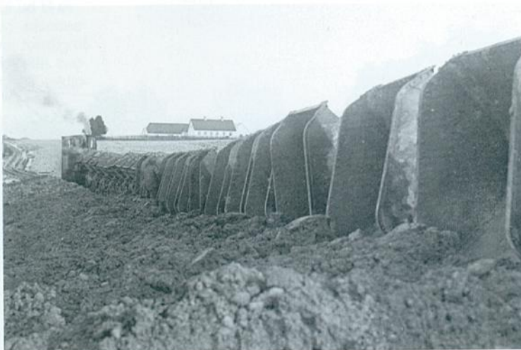
Mergelen læsses af på udvalgte aflæsningspladser
