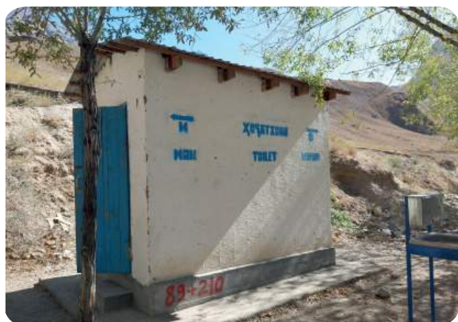
Toilethus – udstyret med hul i jorden og naturligt duft. Man skal altid huske at have toilettejpapir i lommen.
