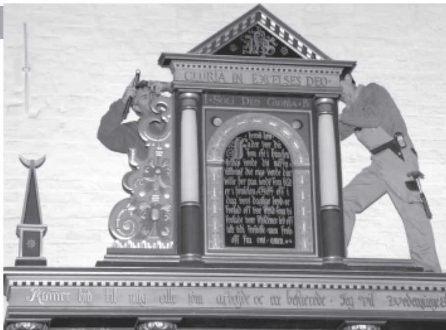
Mandag den 5.11. startede håndværkerne med at afmontere inventaret i Vrejlev Kirke. Her er man ved at fjerne opsatsen oven på altertavlen.
